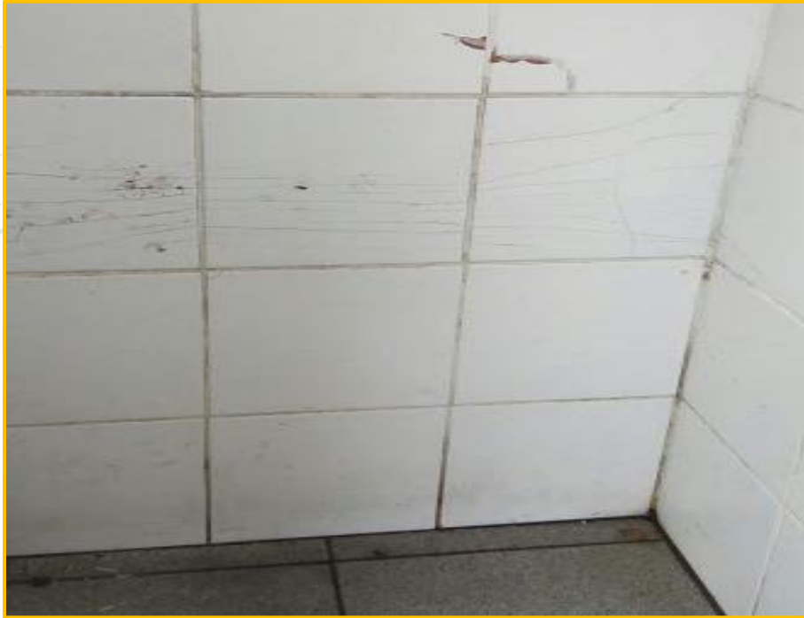
❖ Foto 01: inspección del área a intervenir.
