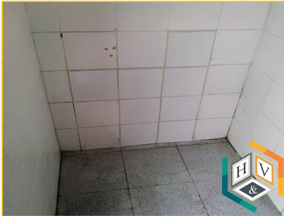
❖ Foto 05: enchapado de cerámico según formato existente.
