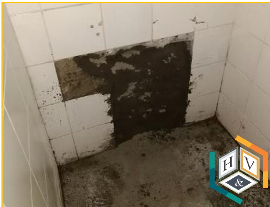
❖ Foto 04: tarrajado y aplicación de aditivo.
