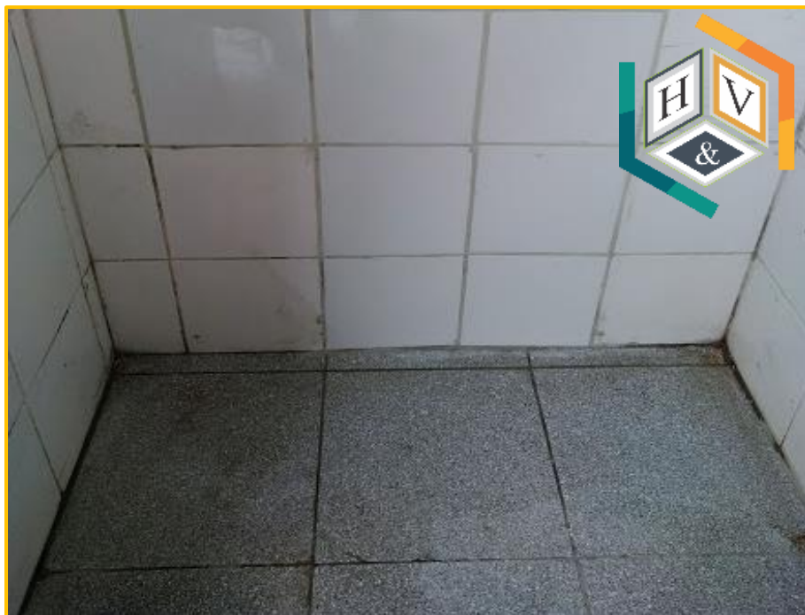
❖ Foto 06: limpieza del área intervenida.
