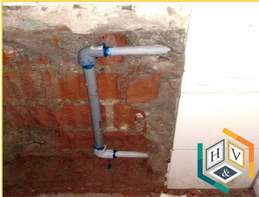
❖ Foto 03: cambio de tubería, pruebas de fuga.
